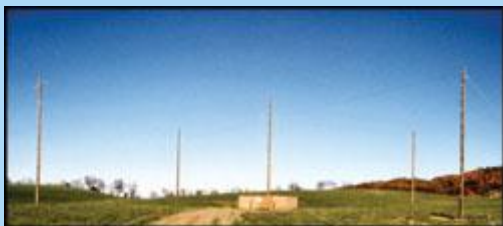
Опытная антенна Kinstar на 1,680 МГц
